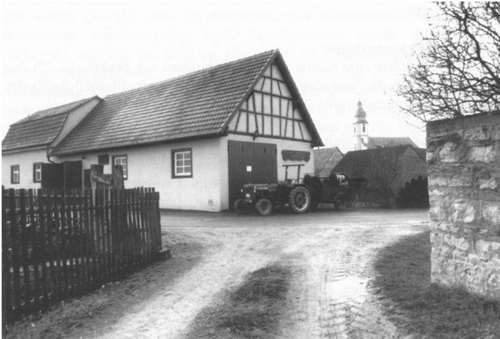
Das neue Feuerwehrgerätehaus
